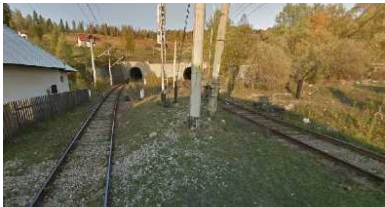
Calea ferat dubl electrificat în zona tunelurilor Mestec ni (traversarea Carpaților Meridionali) (foto: maps.google.com)
