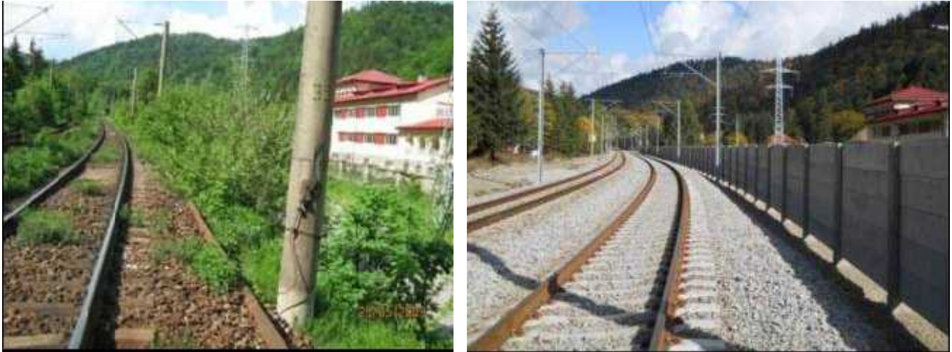
Figura 5.18 Exemplu de linie de cale ferată înainte și după reabilitare
