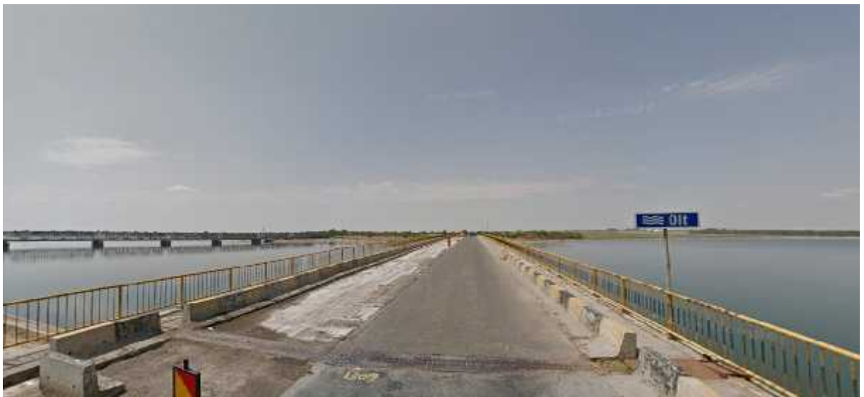
Figura 4.23 Treversarea Oltului în zona Drăgănești constituie principalul sector dificil pentru implementarea proiectelor din acest coridor
