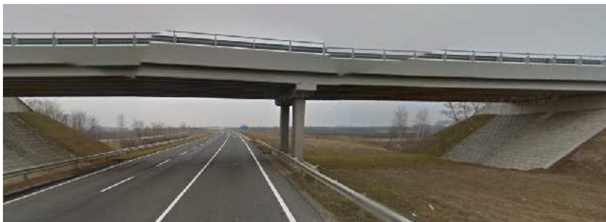
Fig.4.54 – Autostrada M15 half-profile (Budapesta – Hegyeshalom – Bratislava) – cu spațiu liber dedicate dezvoltării ulterioare
