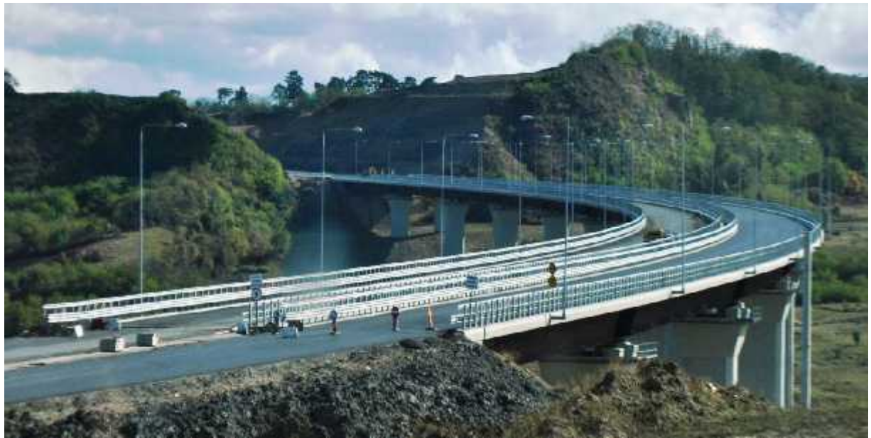
Figura 4.20. Autostrada A1 (sectorul Sibiu - Sebe ) – viaductul Aciliu
